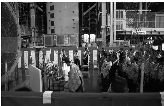
発電機前での安全祈願祭
