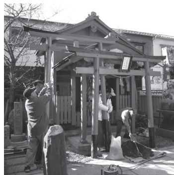
鳥居設置工事と奉納のぼり
