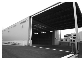
竣工した新工場
