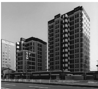
竣工した二棟のマンション
