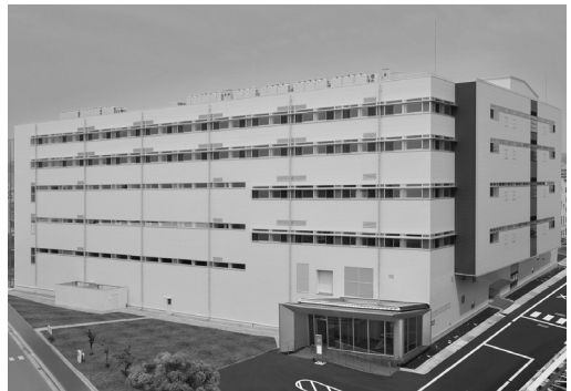
新二一七棟建屋
