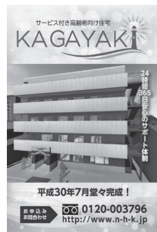
竣工したサービス付き高齢者向住宅
